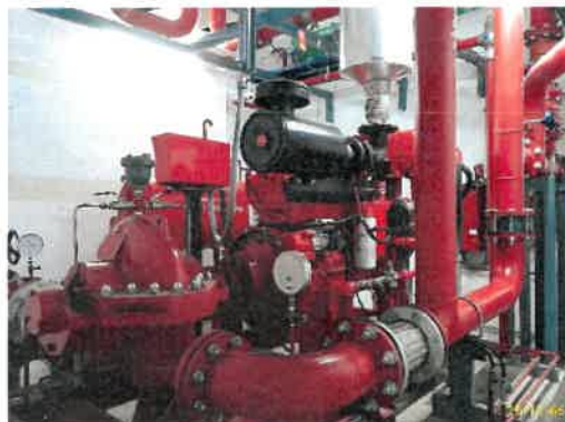
ปั๊ม และถังเก็บน้ำสำรองเพื่อการดับเพลิง
