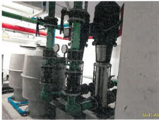
ปั๊ม และถังสำรองเพื่อการอุปโภค-บริโภค ชั้นใต้ดิน
