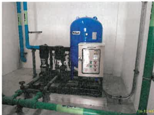
ปั๊ม และถังสำรองเพื่อการอุปโภค-บริโภค ชั้นใต้ดิน
